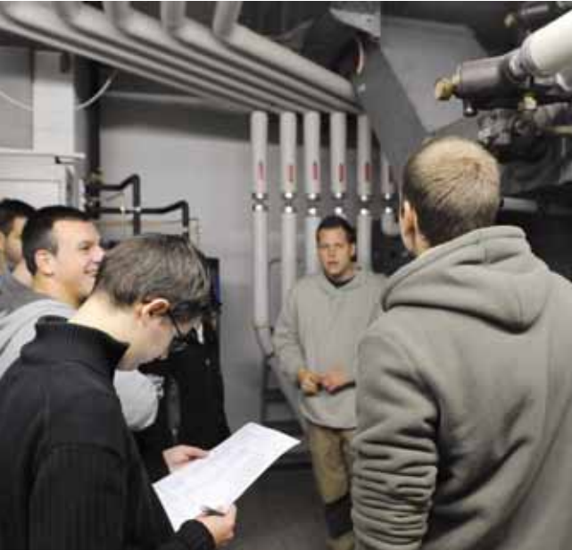
Kontrolle der Lüftungsanlagen mit Hilfe von Checklisten und Ramon Bart ist gar nicht so schwer.
